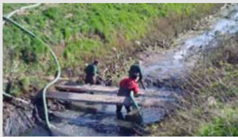
Absaugen des Schlammes aus dem Bachbett.
